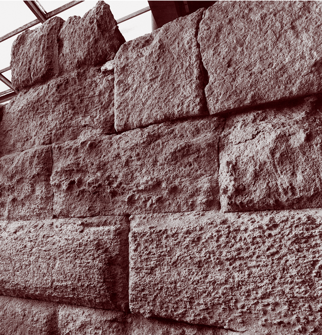
Abb. 10 Polybios und Livius beschreiben präzise die eindrucksvolle karthagisch-hellenistische Ummauerung von Qrt Hadašt – spanische Archäologen fanden sie an der angegebenen Stelle. In bester hellenistischer Mauerbautechnik ausgeführter Abschnitt der Stadtmauer von Carthago Nova am nordöstlichen Rand der antiken Stadt.
