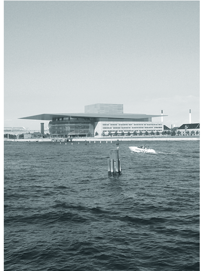
Blick über den Hafen auf die Oper
