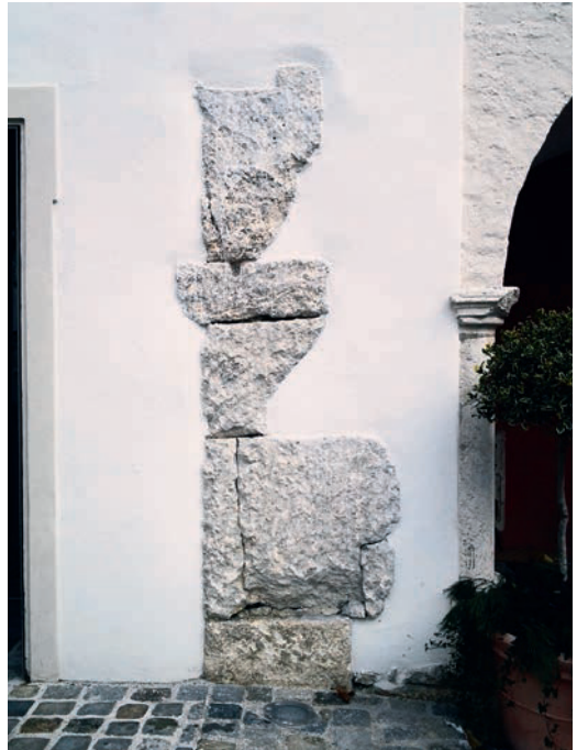
Schnitt der Legionslagermauer bei „Unter den Schwibbögen 2“ mit Erhaltung des Wehrganges.
