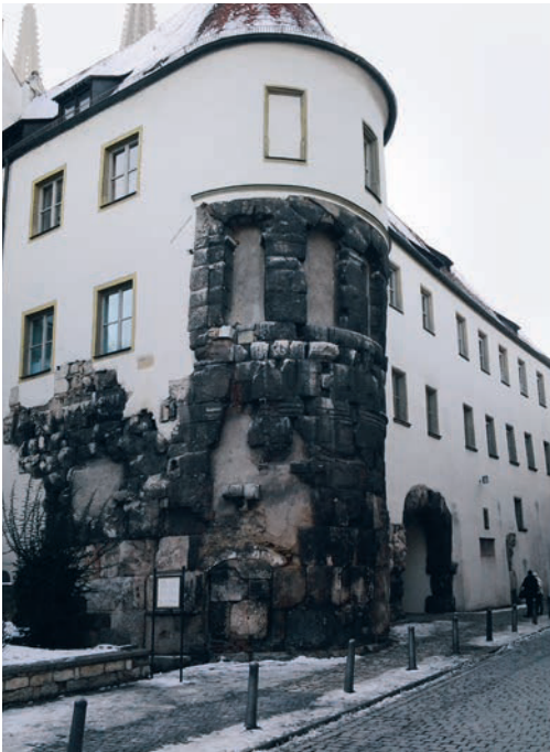
Die porta praetoria des Legionslagers integriert in den Bau des Bischofshofes.
