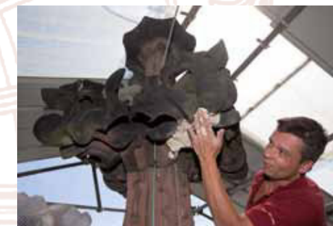
Vorbereitung von Kompressen zur Steinentsalzung.
