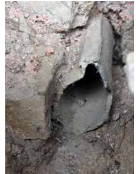
Abb. 28: Abflussrohr aus Blei der großen piscina der Bauphase III.
