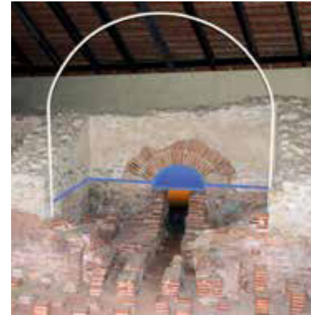
Abb. 30: Die testudo -Öffnung im Mauerwerk.
