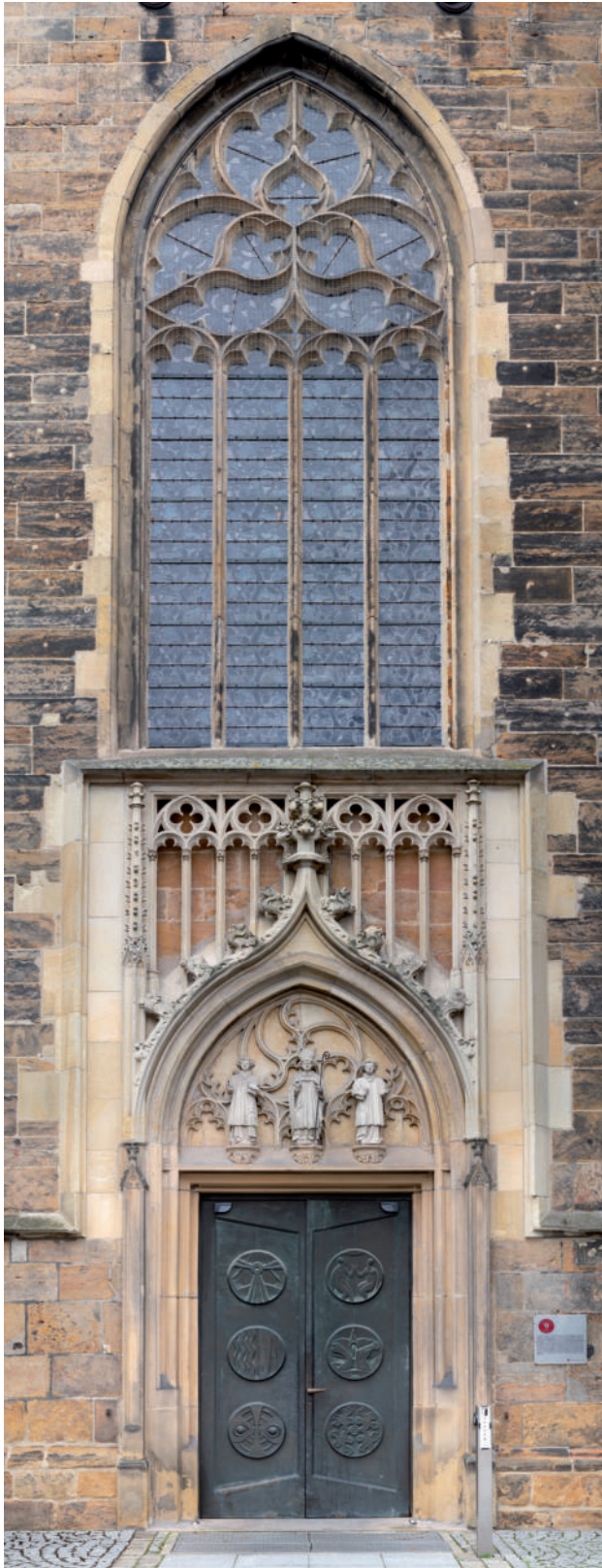
Abb. 3: Brautportal der Südfassade und Fenster des vierten Joches von Osten, Rheine, St. Dionysius.
