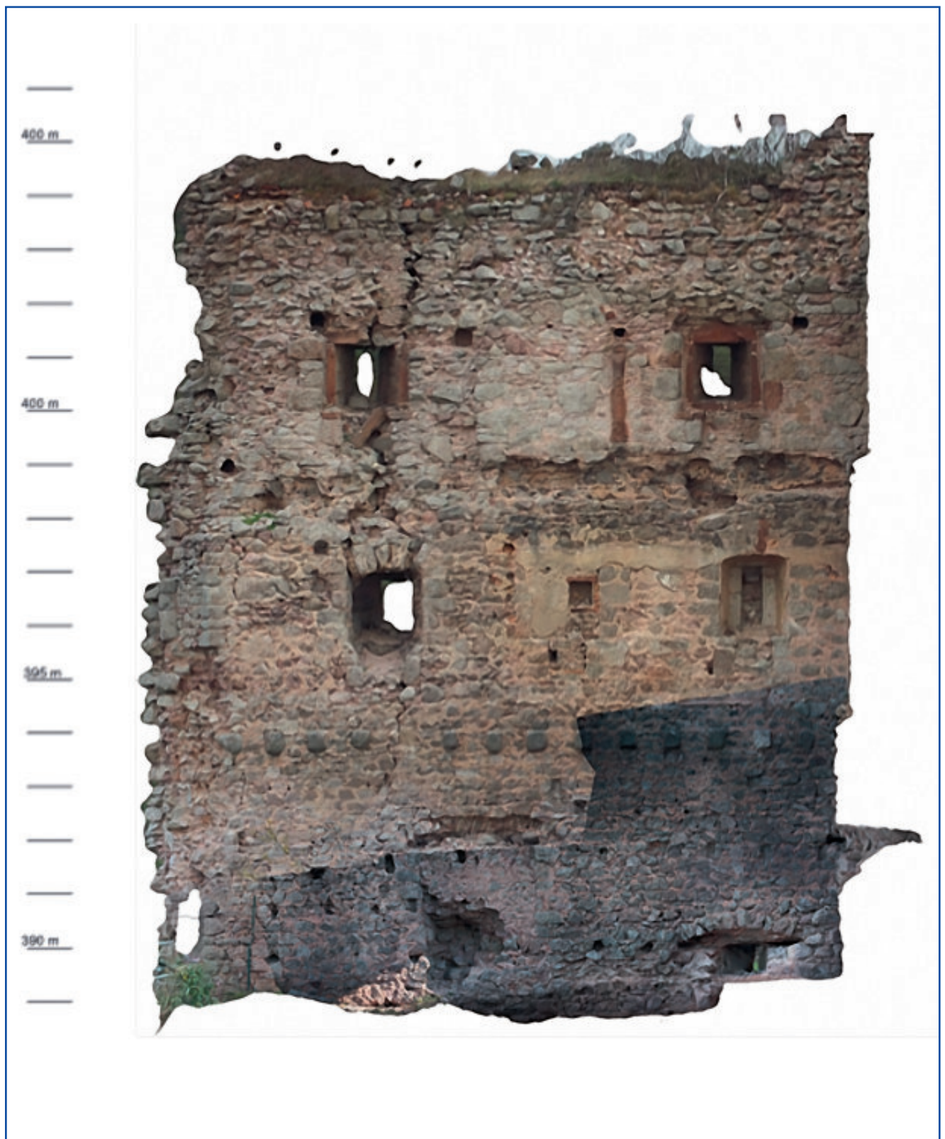
Abb. 5: Orthobild des inneren Mauerwerks, Burg Ramstein bei Scherwiller.
