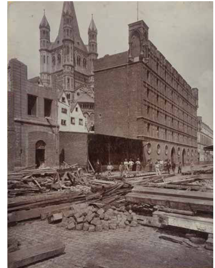
Abb. 15: Rudolf Dohmen, Köln – Frankenwerft mit Kaufhaus Ahren kurz vor dem Abbruch, 1898, G 27924.
